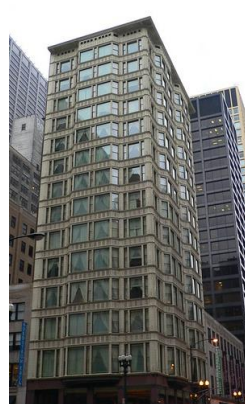
릴라이언스 빌딩 (Reliance)
